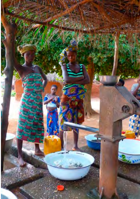
Borgou – Puits protégé doté d’une pompe manuelle
